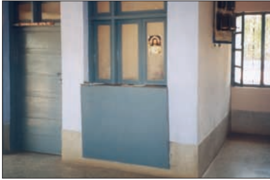
← Kamer voor de generator en de patiëntenfiles
