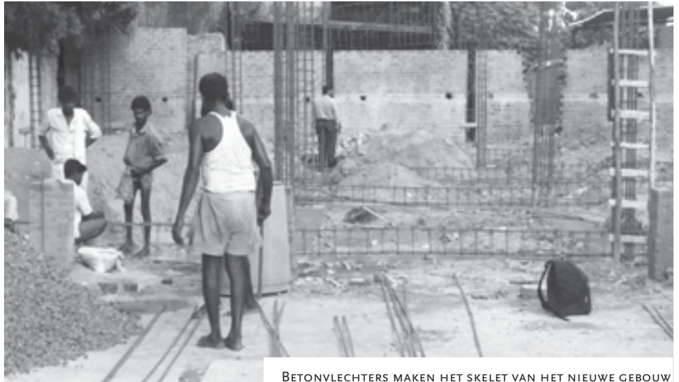
BETONVLECHTERS MAKEN HET SKELET VAN HET NIEUWE GEBOUW
